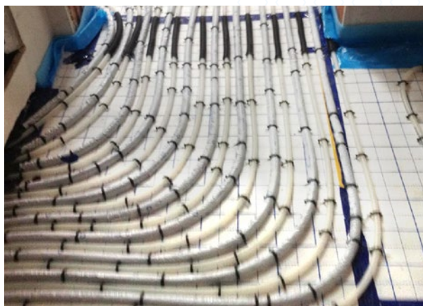
bavaria-DLZ-Dämmung auf Flies-Tackersystem
