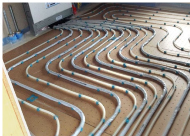
bavaria-DLZ-Dämmung auf bavaria-Biofaser-Lochplatte
